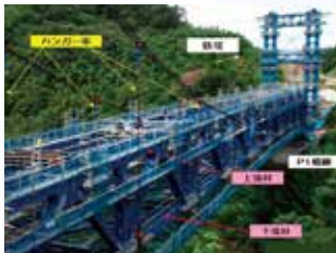
ケーブルエレクション直吊工法 架設計画・架設計 [製作・架設会社向け]
