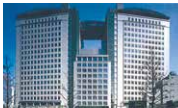
大学校舎鉄骨造（一部鉄骨鉄筋 コンクリート造）地上20階、地下2階、 塔屋1階、延べ面積 56,300㎡
