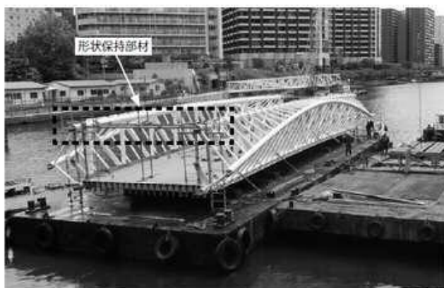
写真-12 台船運搬および形状保持部材
