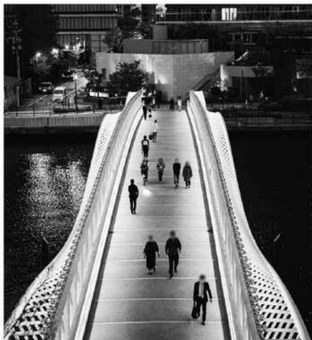
写真-14 供用中の黎明小橋
