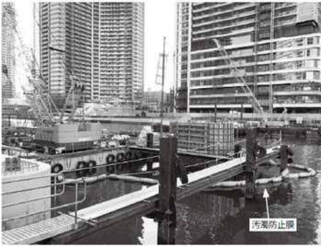
写真-6 汚濁防止膜
