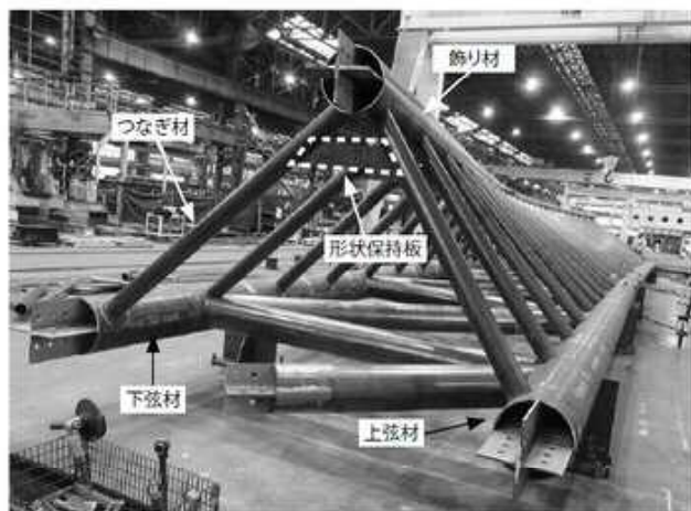
写真-9 主構部と飾り材部の組立て
