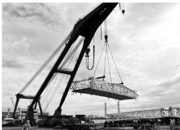
写真-11 400t吊り起重機船による浜出し
