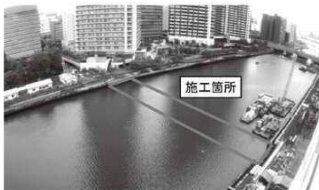
写真-4 施工箇所
