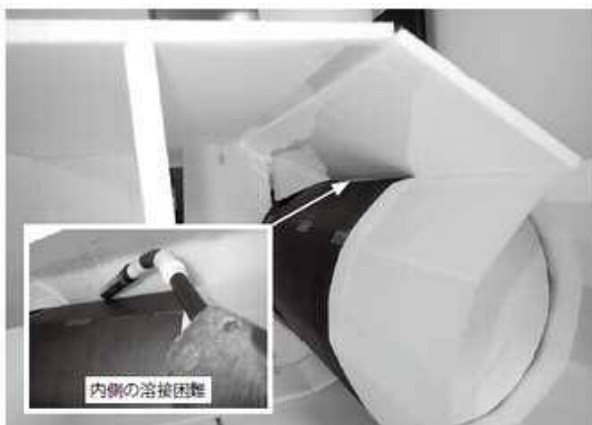
写真-8 デッキプレートと下弦材の溶接部
