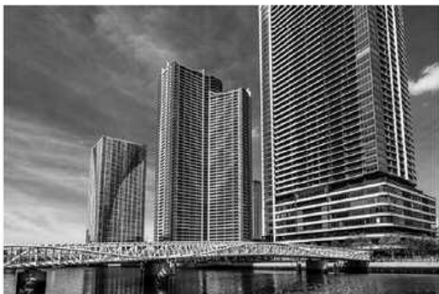
写真-1 黎明小橋全景
