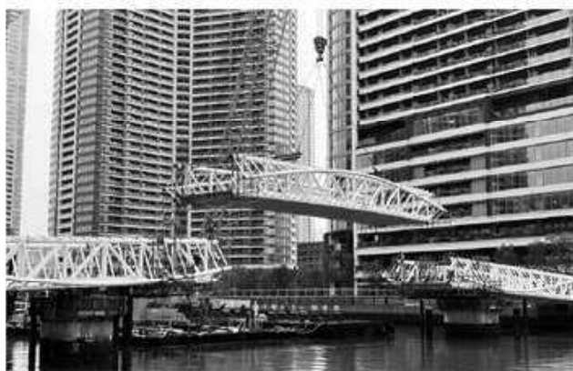
写真-13 桁架設(中央径間架設)
