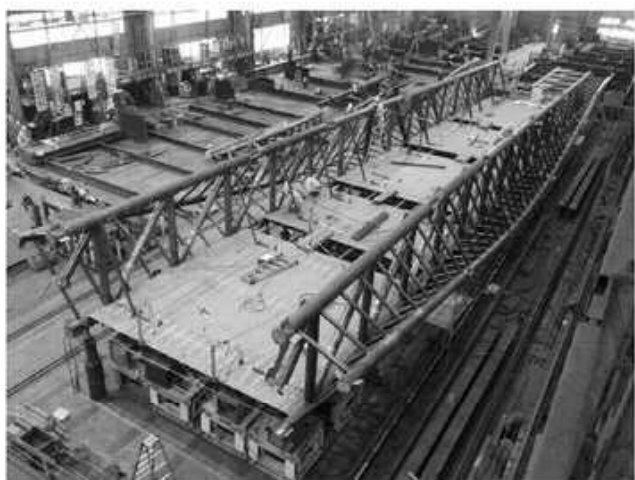
写真-10 部分仮組立て(GE1～J-5ブロック)
