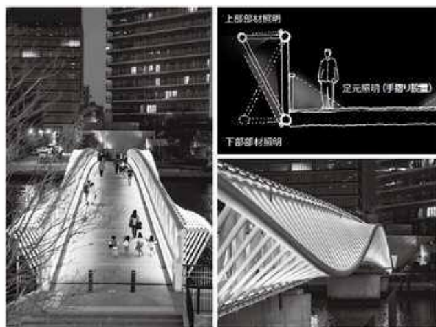
図-9 黎明小橋の照明設備
